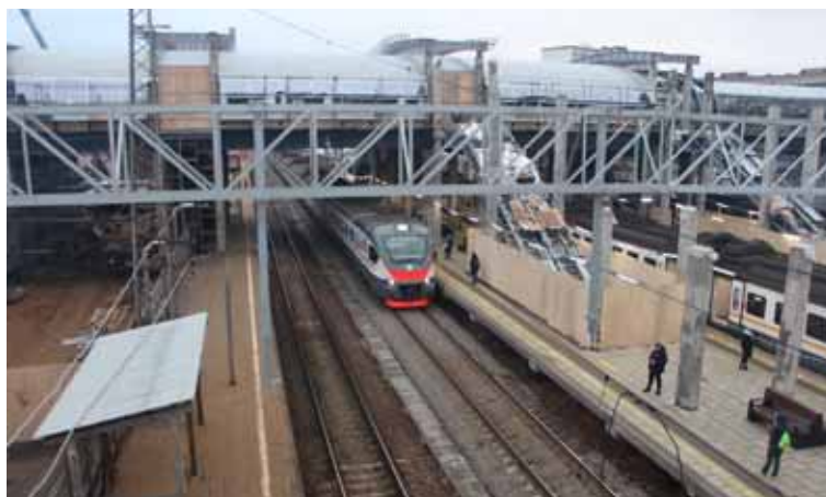
▼ Реконструированная станция Нахабино, от которой начинается теперь ветка наземного метро Московского центрального диаметра «Нахабино-Подольск» (МЦД-2).
